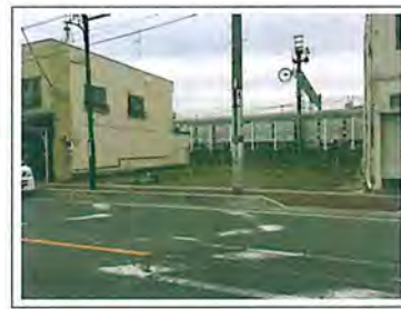
従前の当該敷地風景。真ん中に電柱があり、駐車場としての使用は困難でした。後方が駅のホームです。
