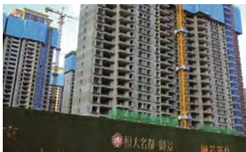
恒大の多くの建設現場が資金難で止まっている
