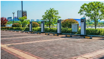
北海油田・ガスの輸出で得た収益を全国2万ヶ所のEV充電インフラ設置とEV車購入補助金に充当
